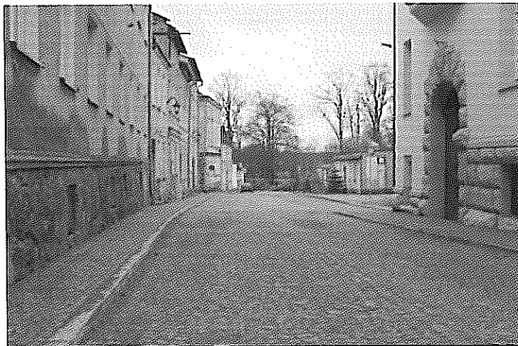
Rys. nr 4 Przebudowana ulica Waryńskiego w Karlinie
